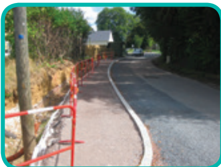
Rénovation chemin du Roy
